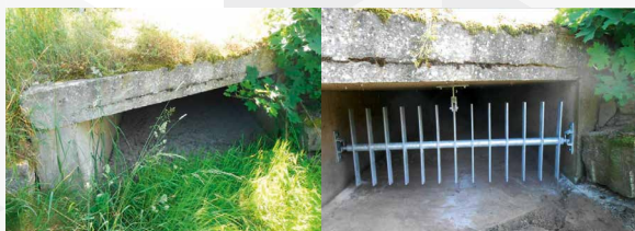
Auslassbauwerk vorher/nachher mit drehbarem Rechen zur Reinigung.
