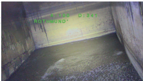
Abbildung 2: Kanalspiegelbild eines unterirdischen RÜBs
