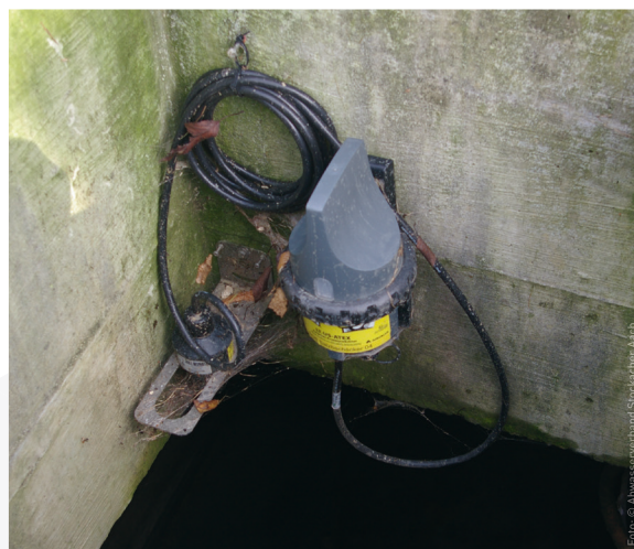
Abbildung 2: Montage des Prozesswächters
