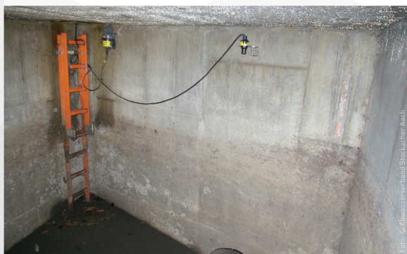
Abbildung 3: Montage des Prozesswächters 2
