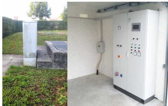
vorher: Freiluftschaltschrank nachher: Betriebshäuschen/Fertigarage (zeitgemäßes Arbeiten, bessere Hygiene durch Handwaschbecken und generelle Werterhaltung)
