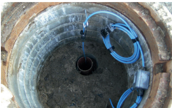
Abb. 3: Wartungsfreundlicher Einbau einer Drucksonde
