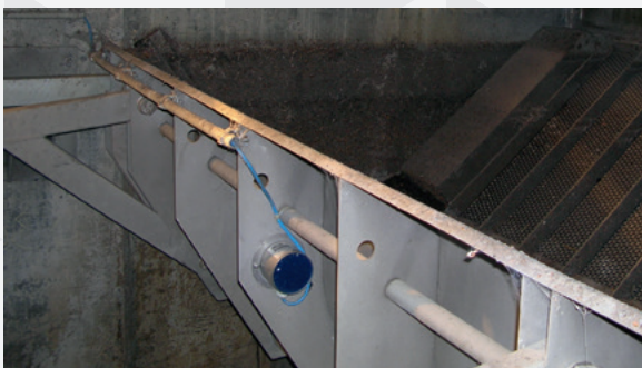
Abb. 4: Drehwinkelgeber an einer Stauklappe
