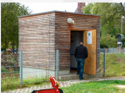
Abb. 4: Betriebshütte für Betriebs- personal und Schaltanlagen
