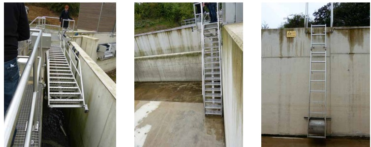
Abb. 5: Zeitgemäße, den UVV entsprechende Einstiege in Regenbecken
