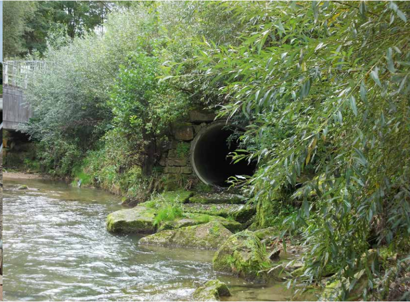
Abb. 3: Einleitungsstelle der MW-Entlastung
